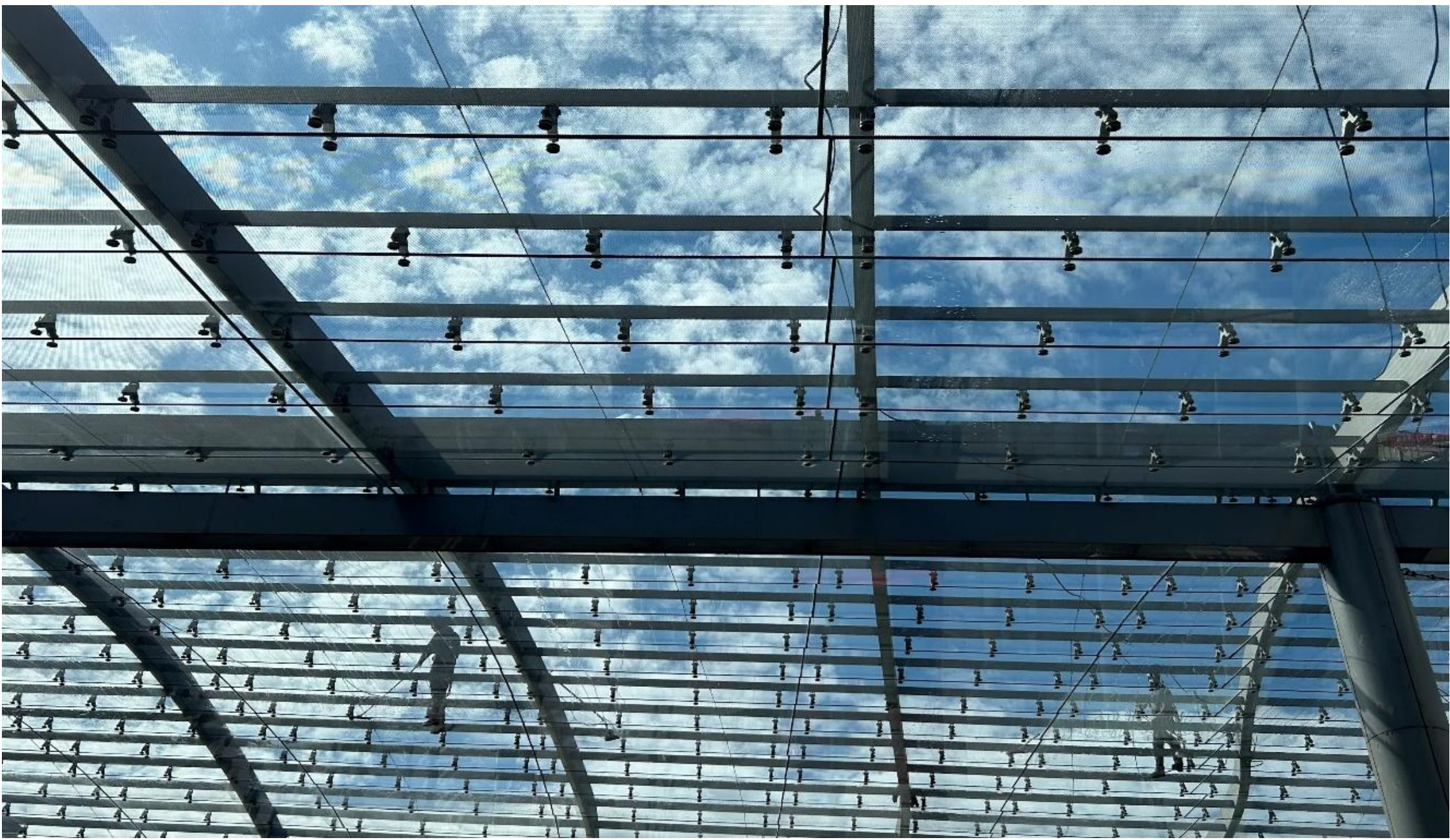
Abb. 6 Reinigungsarbeiten Glasbaldachin Bahnhof Bern
