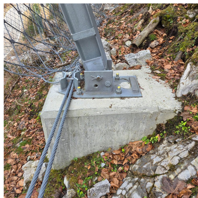
Abb. 1: Gelenkiges Stützensystem
