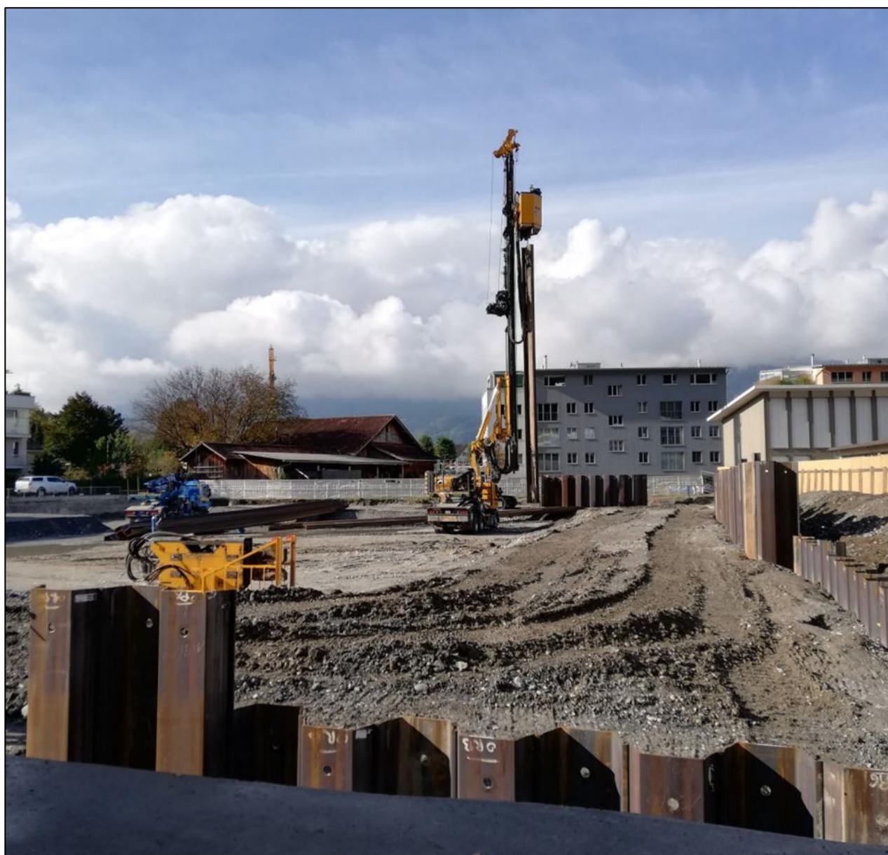
Abb. 1: Einbringen der Spundwand
