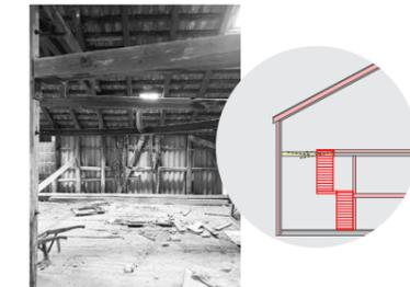
An der Position des bereits beschädigten Bodens, wird die neue Treppe platziert. Die Decke wird weiter im Raum innern gestützt.
