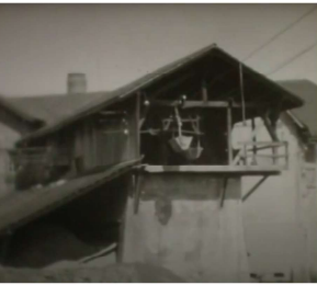
Abbildung: Aufnahme der Seilbahnstation im Betrieb (1934)
