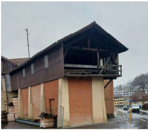
Abbildung: Aufnahme der Seilbahnstation ausser Betrieb (2025)
