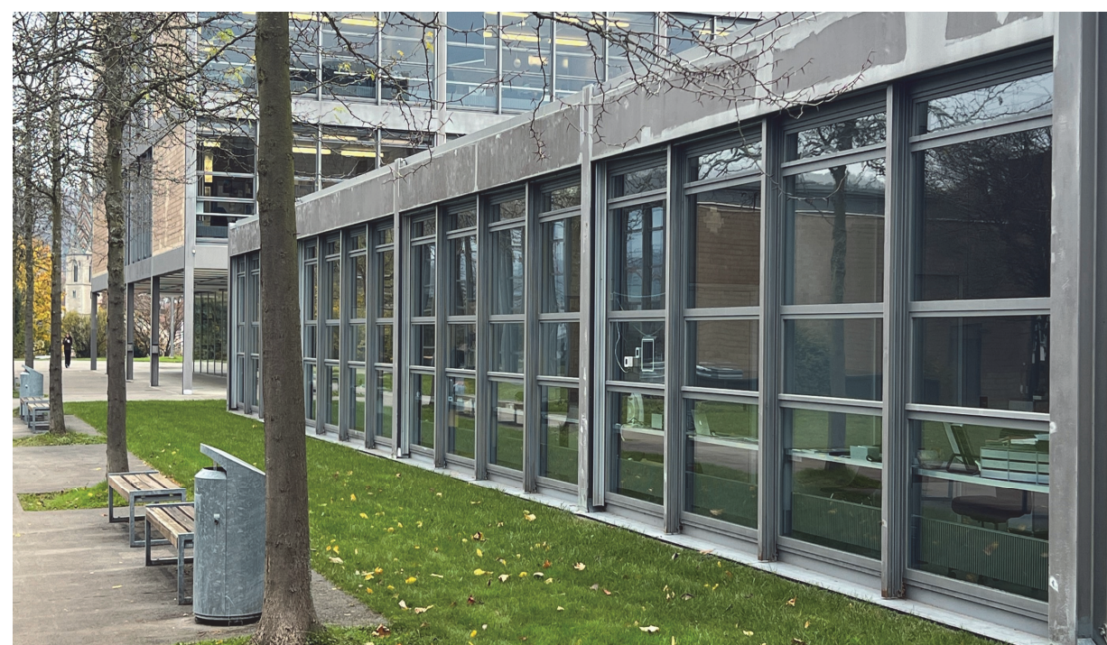
Abbildung 2 – Südwestfassade, Gebäude 4, Kantonsschule Baden
