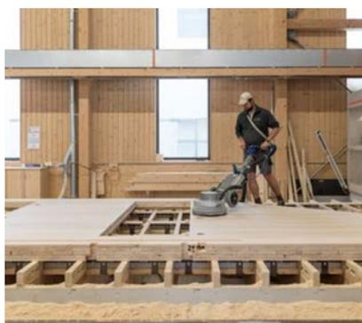
Abb. 51. Oberflächen der Holzpur Elemente werden geschliffen.
