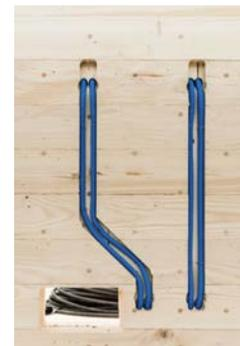
Abb. 53. Installationen werden in das Element integriert.
