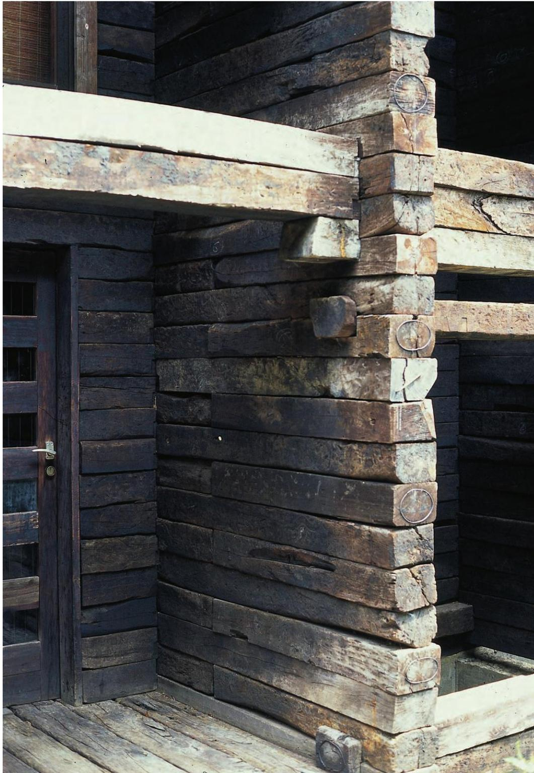
Abb. 30. Die Seitogakushi Schule in Japan wurde mit gebrauchten Eisenbahnschwellen gebaut.
