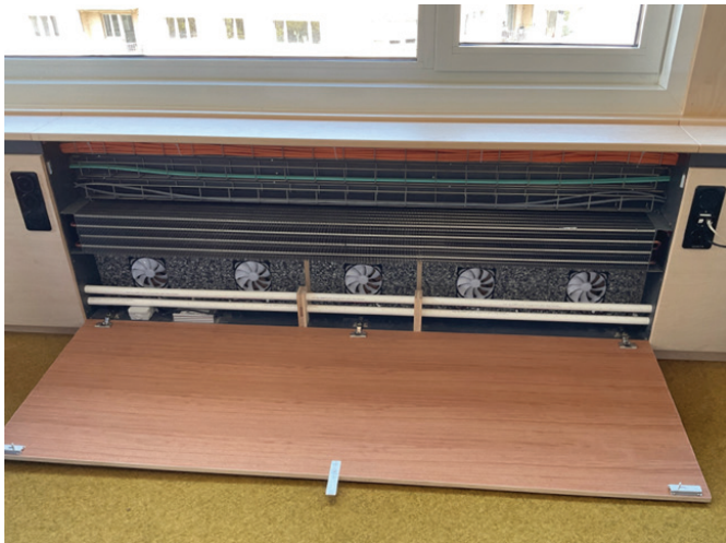
Abb. 1: Ein Klimakonvektor der Firma «Kegel Klimasysteme», in Zürich verbaut, mit den aktuell genutzten Axialventilatoren
