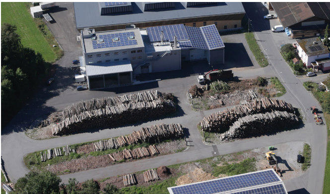
Abb. 1: Holzheizwerk der Korporation Alpnach
