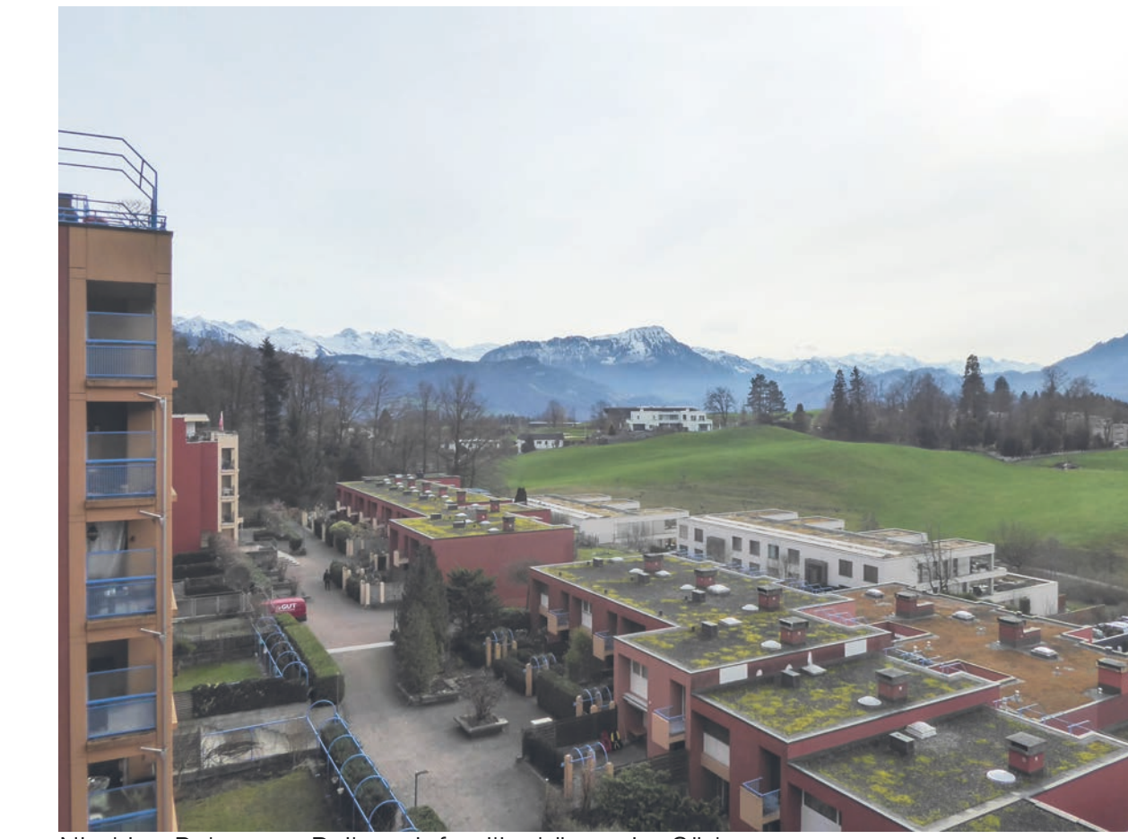
Niedrige Bebauung Reiheneinfamilienhäuser im Südwesten
