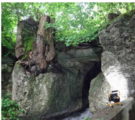
Abb. 1: Ausgang Bachdurchlass (Tiefbauamt Kanton Schwyz, 2013)
