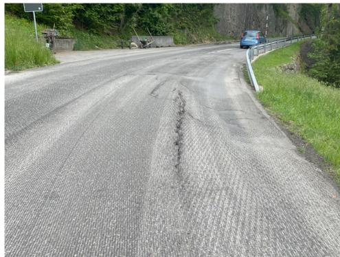
Abb. 2: Schäden in der Tragschicht
