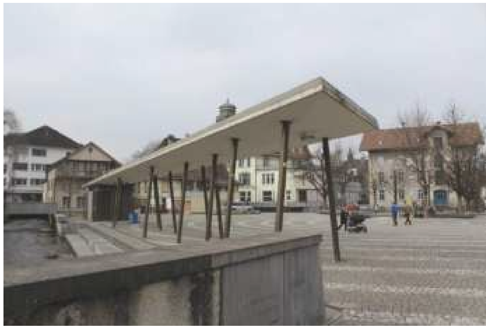
Zugang zur Langete beim Wuhrplatz
