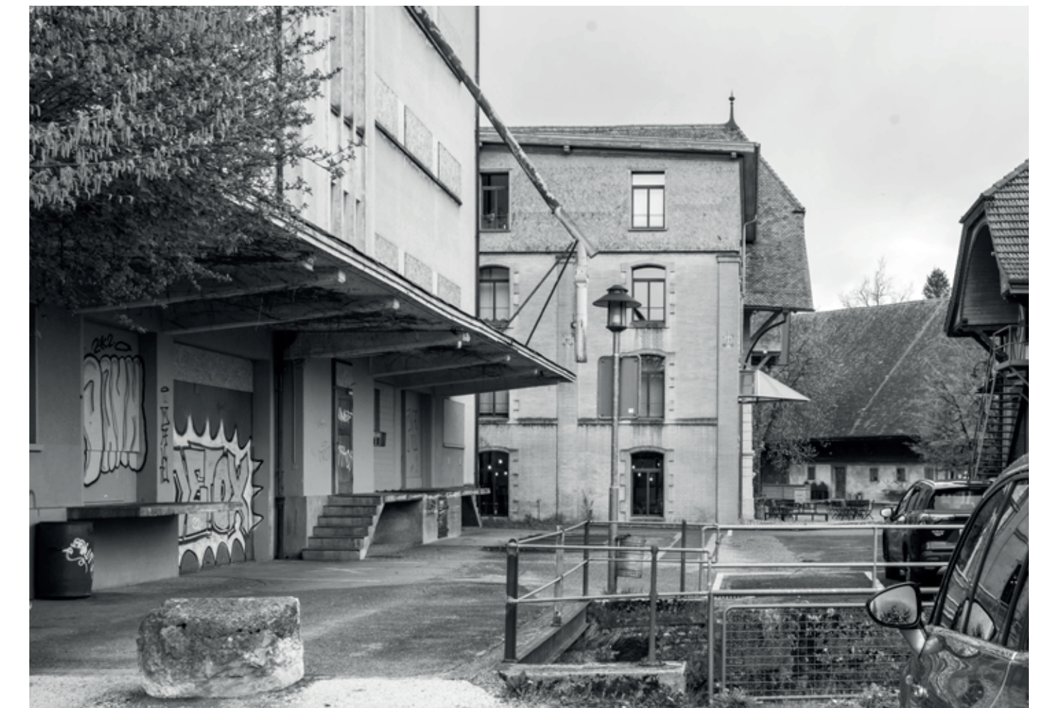
Fotografie Aussenplatz im Süden des Silogebäudes, bestehend
