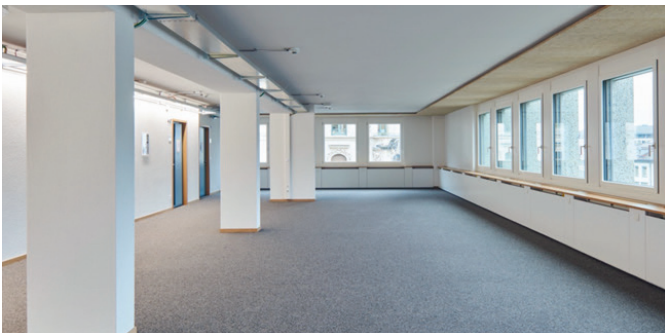
Abb. 2: Bürogebäude mit Klimakonvektoren in St. Gallen
