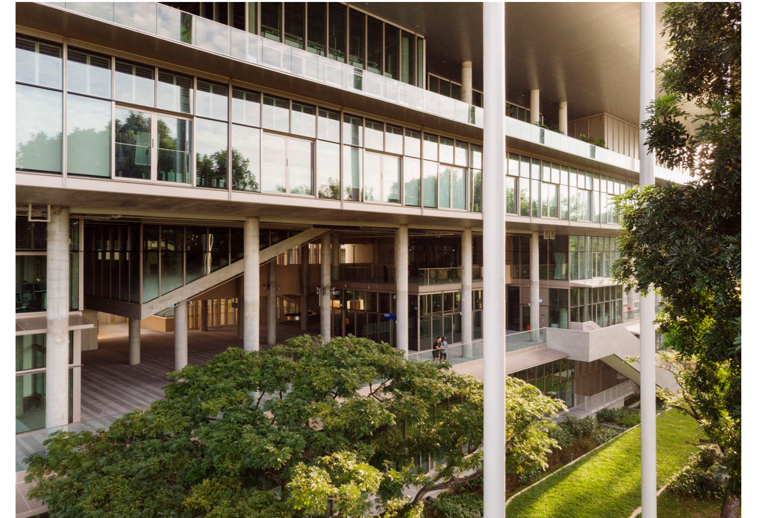
© Beispiel für ein Low-Tech Gebäude in Singapur
