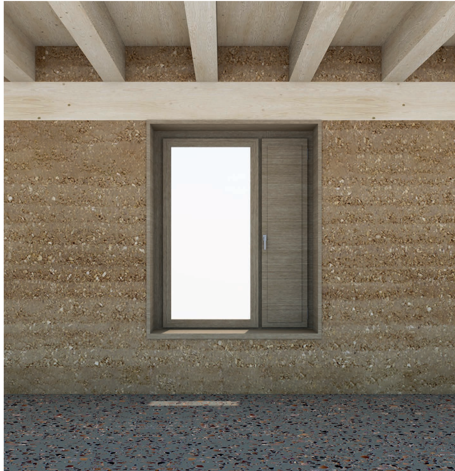
Innenansicht Fenster Südseite mit sichtbarem Lüftungsflügel.
