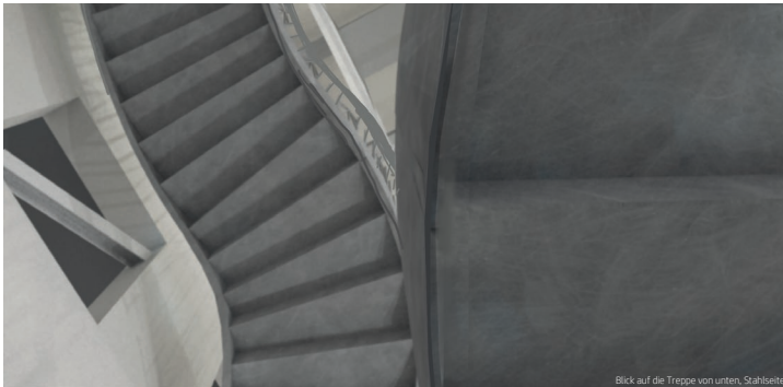
Blick auf die Treppe von unten, Stahlblech
