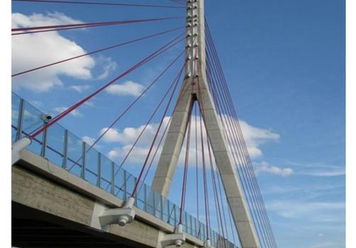
Beispiel für Anschluss der Schrägkabel
