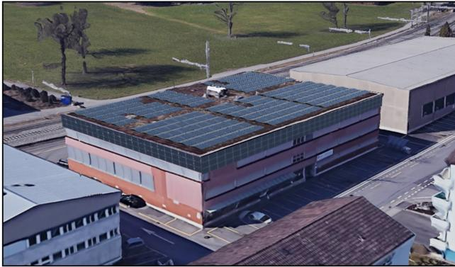
Abbildung 1: Ansicht Gebäude mit empfohlener 200 kWp PVA
