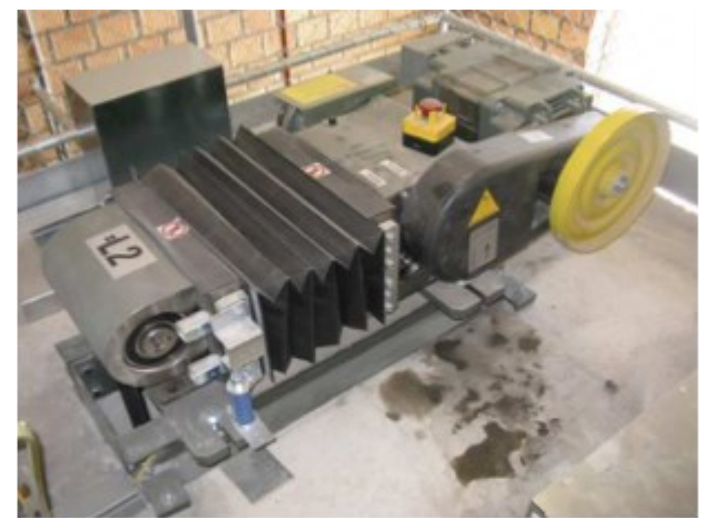
Abb. 04: Neuer Liftmotor SGB142
