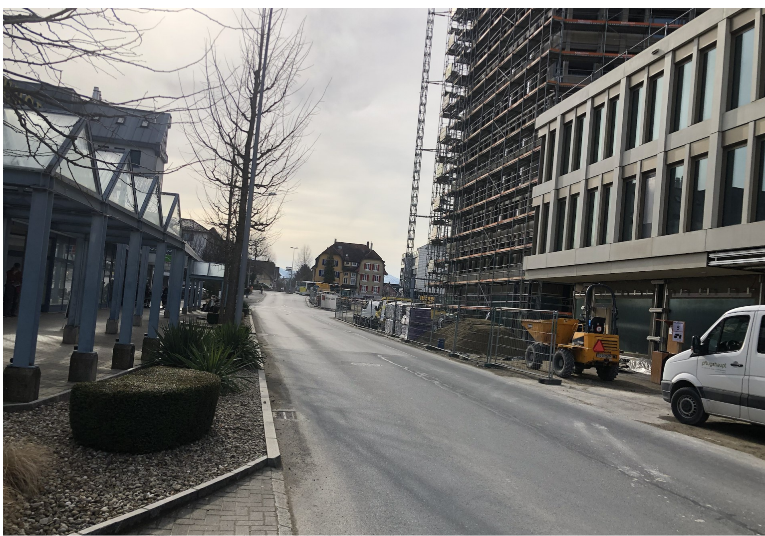
Bestehender Strassenraum Abschnitt 2
