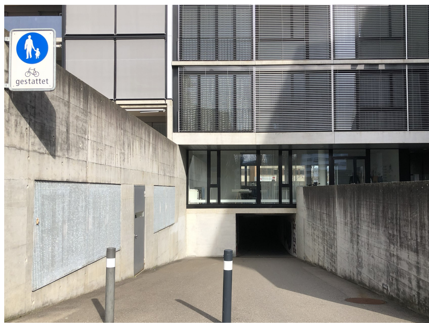
Bestehende Unterführung Abschnitt 1
