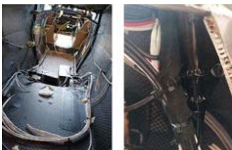
Abb. 3 Montage des Kabelbaumes
