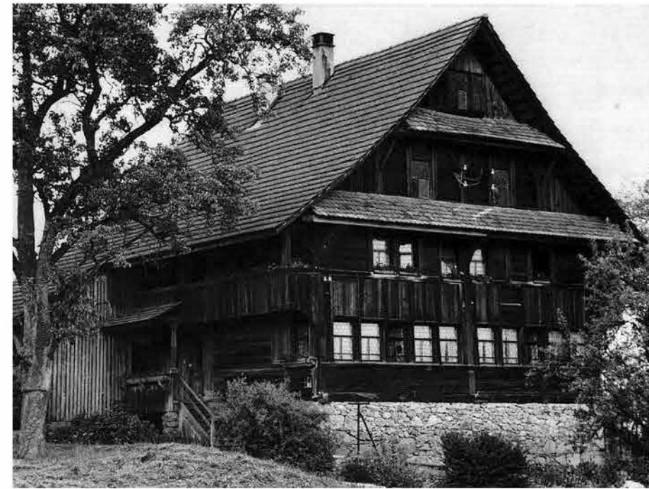
Steilgiebliges Wohnhaus (18./19. JH)
