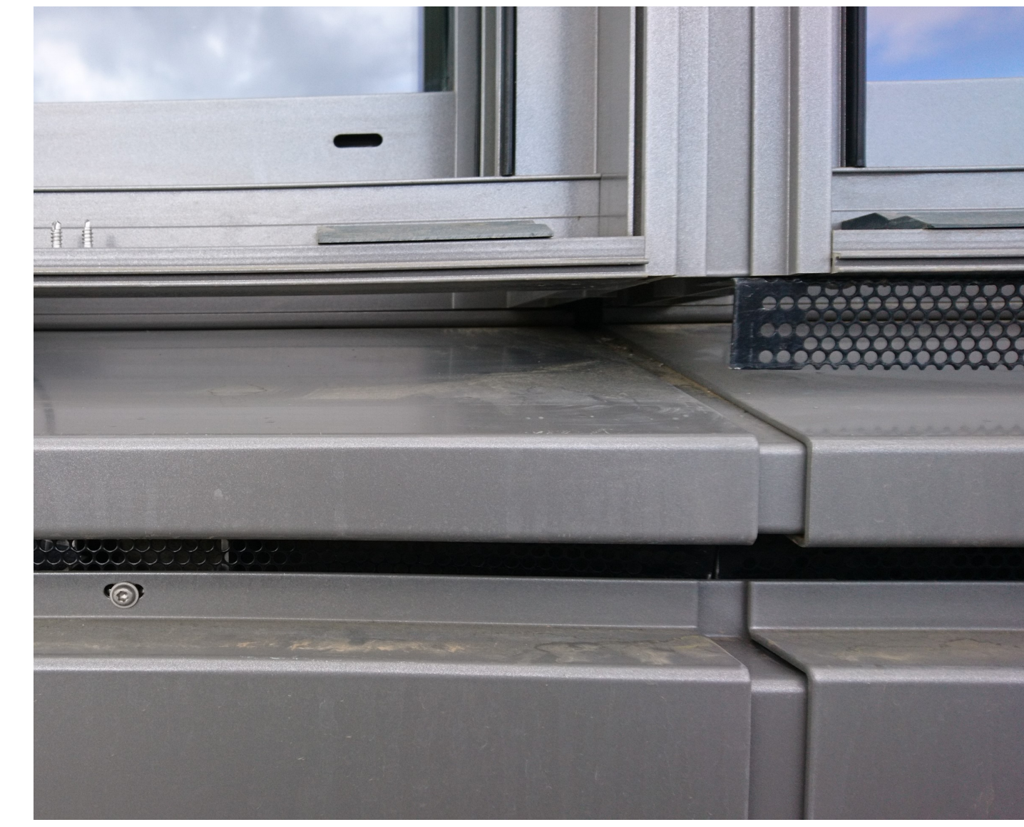
Abbildung 6: Untere Manipulation der Fassade, Lochblech bei Belüftung entfernt bei Fenster 2 und Fenster 4.
