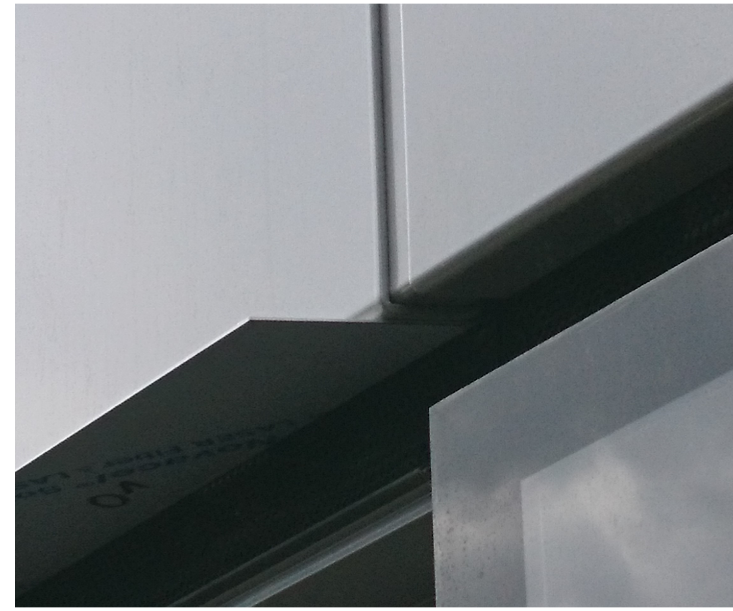
Abbildung 5: Obere Manipulation der Fassade, Feuchteintritt durch Blech minimiert bei Fenster 3 und Fenster 4.
