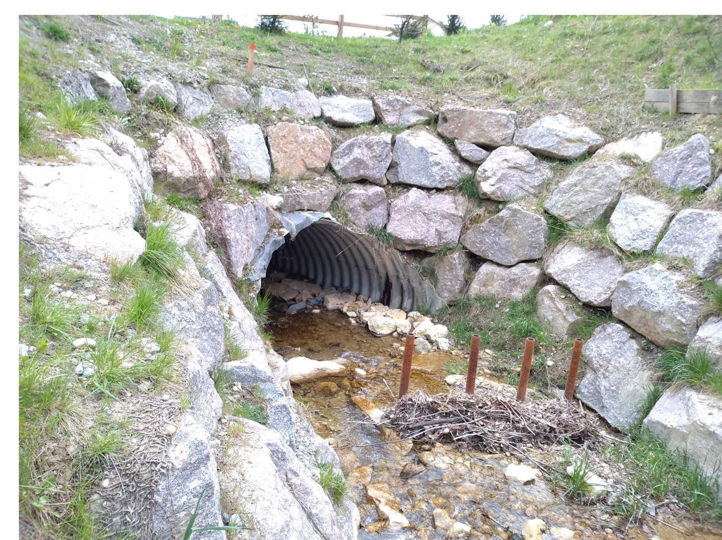
Abbildung 6: Gute Einlaufgestaltung: Böschungssicherung aus Blocksteinen, natürliche Gewässersohle, zurückversetzter Stabrechen, einseitiges Bankett (Murer, 2021)
