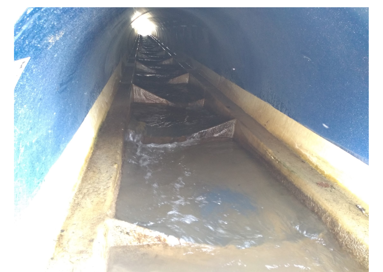
Abbildung 9: Ökologische Aspekte: Fischgängig durch Querbauwerke, starke Turbulenzen und glatte Rohroberfläche verhindern natürliche Sohlenbildung, Bankette zu schmal und rutschig (Murer, 2021)
