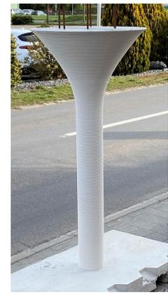
Pilzkopfstütze — Praktische Umsetzung mit 3D-Betondruck Technologie
