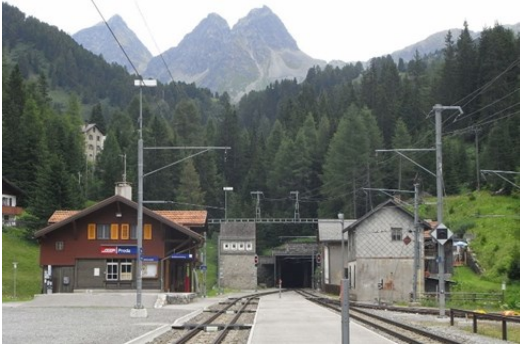
Abbildung 1 — Ansicht an den bestehenden Albulatunnel und den Bahnhof in Preda (Oberlack, 2008)
