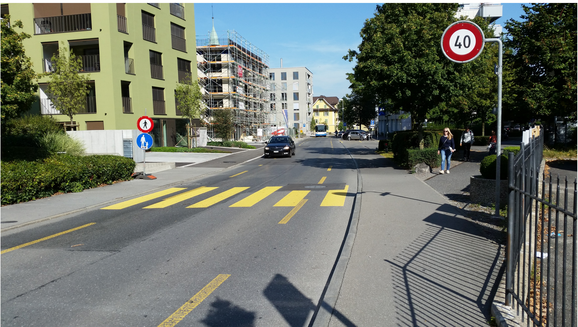
Zentrumsabschnitt der Schachenstrasse
