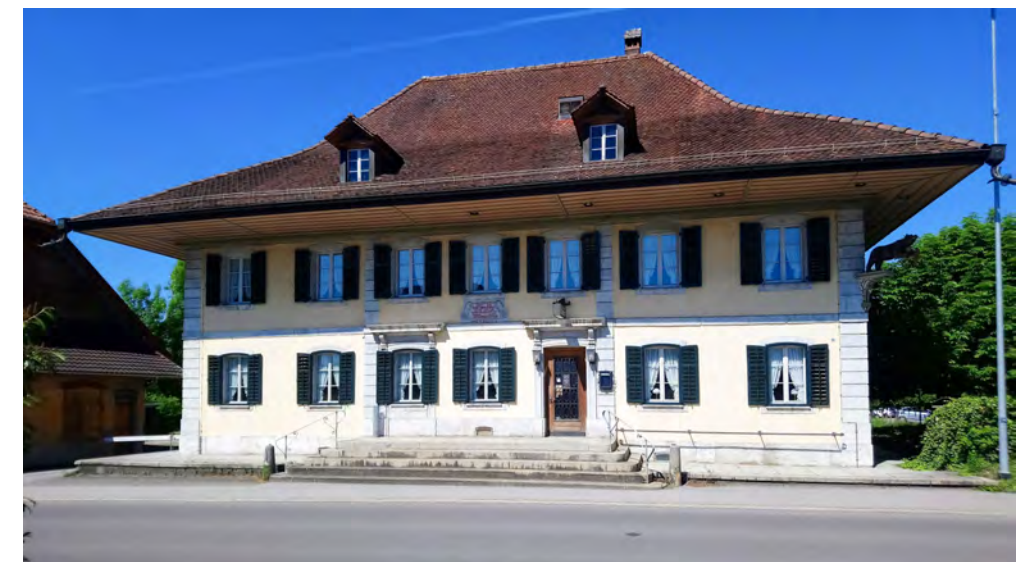
weit auskragende Vordächer
