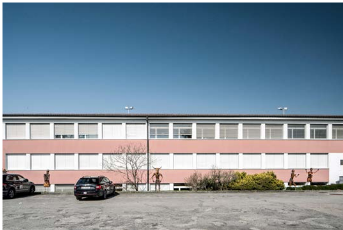
plastische 60er Jahre Fassade der Oberstufenschule
