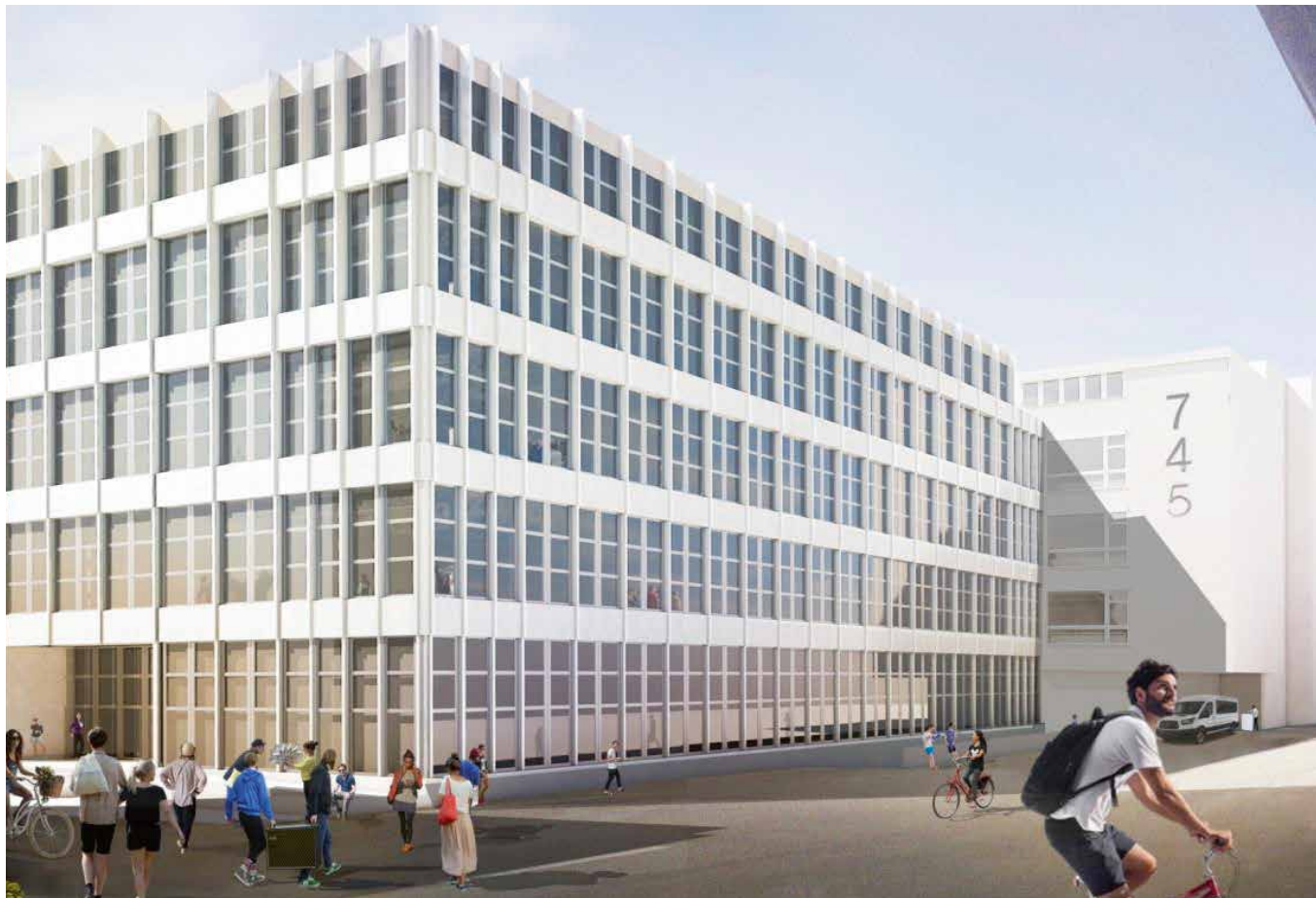
Der Standort der Hochschule Luzern – Design & Kunst in Emmenbrücke erfährt bis 2019 einen weiteren Ausbau.
