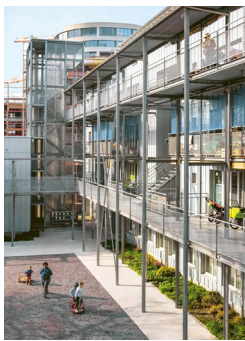
Abb. 63. Die Laubengänge als Erschliessung, war zur Bauzeit eine neue Entwicklung, die Erschliessung, Aufenthalt und Bezugnahme zum Aussenraum ermöglicht
