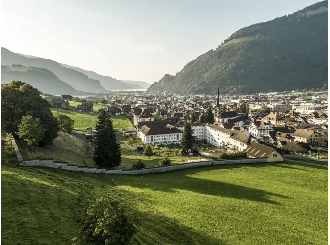
Abb. 18. aktuelle Aufnahme Klosteranlage St. Klara
