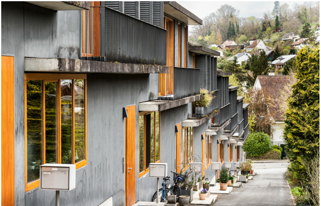
Abb. 65. Eingangsbereich Wohnsiedlung Spittelhof
