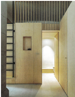
Abb. 74. Die Einbauten verbinden mehrere Funktionen, Einbauschränk und gleichzeitig Badezimmer
