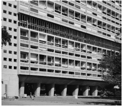
Fig.25. Unité d'habitation, Marseille
