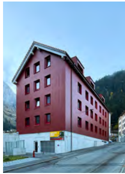
Abb. 25. Die "Casa Gotthardo" im schattigen Oberdorf, direkt neben dem Bahnhof.
