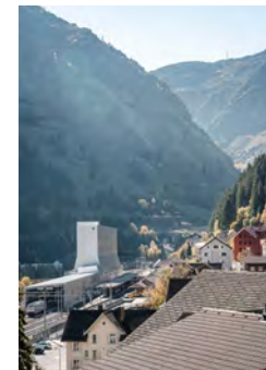
Abb. 18. Die Infrastruktur der Baustelle der zweiten Strassenröhre dominiert das Dorfbild im östlichen Teil.
