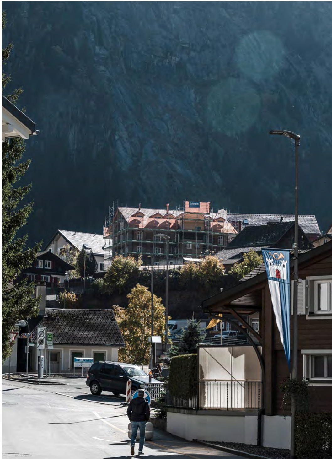
Abb. 23. Blick von der Dorfwiese zum ehemaligen Hotel Krone. Dieses wird derzeit zu exklusiven Ferienwohnungen umgebaut und zeigt damit den Trend zum reinen Renditeobjekt im Dorf.
