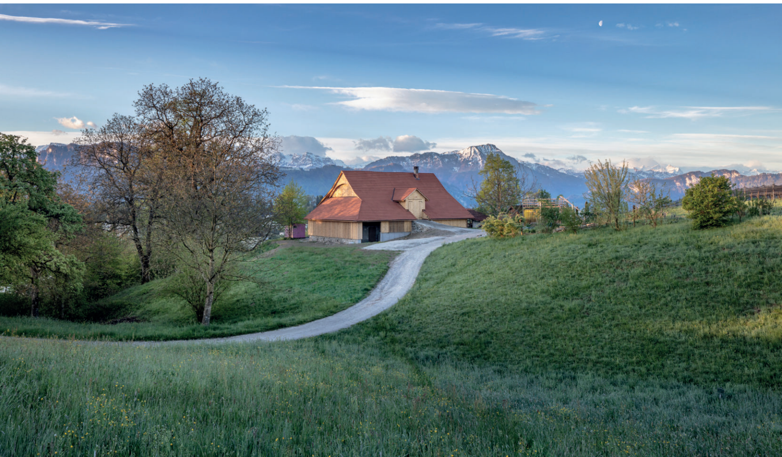
Abb. 3 Sanierung Wohn- und Ökonomiegebäude Sensible Erneuerung ausgehend vom Bestand
