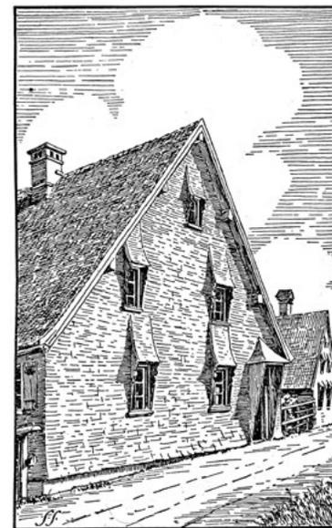
Abb. 024: Hinterseite; Schindelschirm mit Fensterschutz
