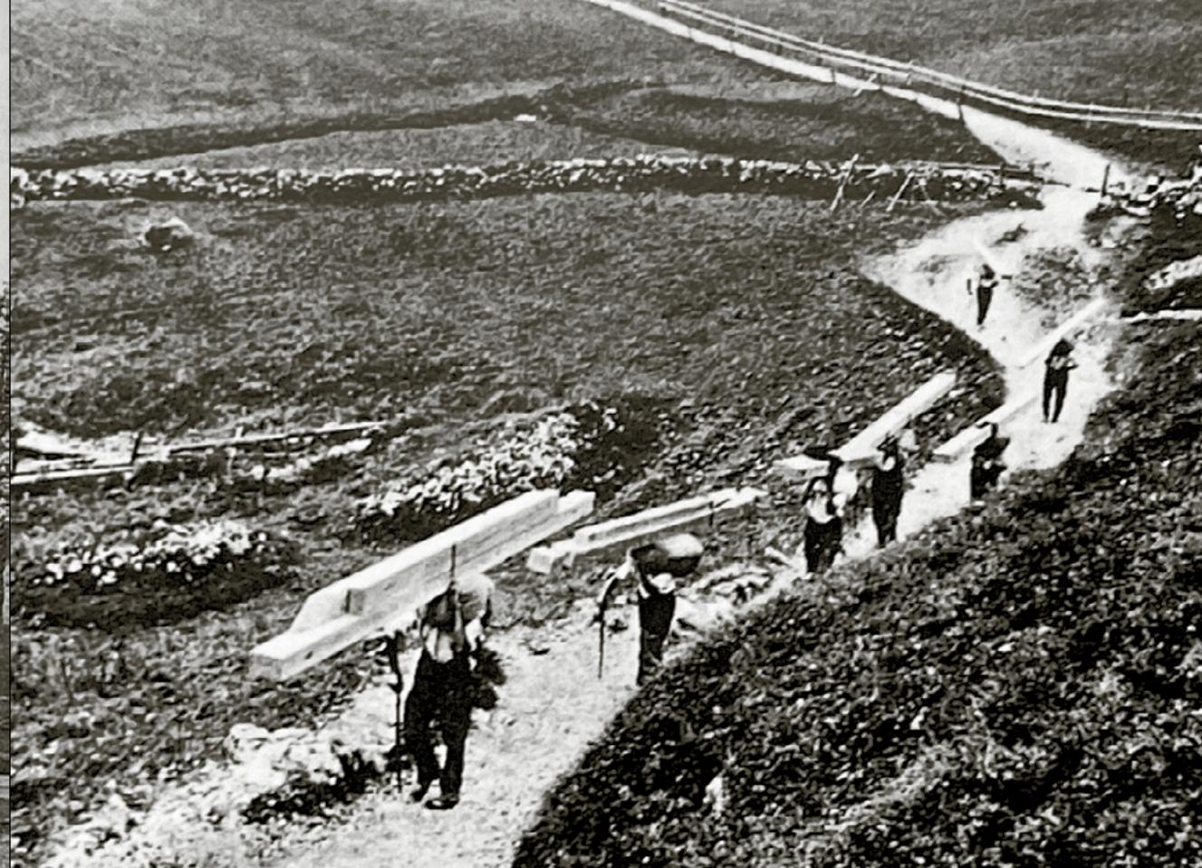
Abb. 017: Ein transportables Baukastensystem: Aufstieg mit Bauteilen
