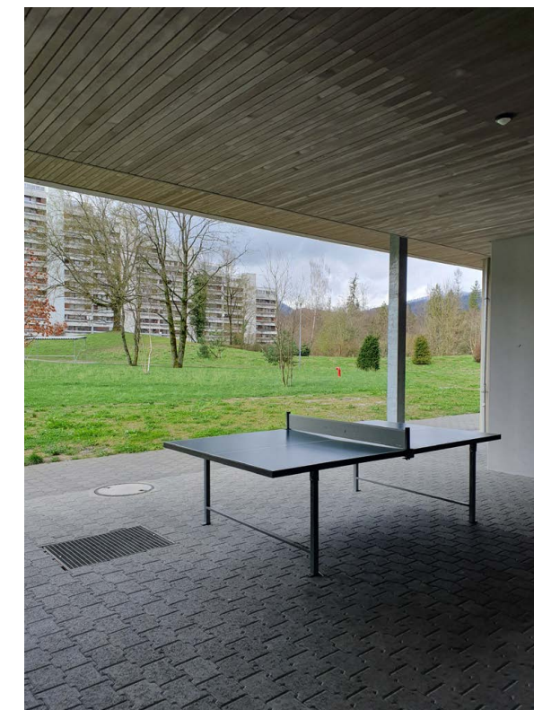
Arkaden im Erdgeschoss (rechts unten eine Depotstation für Einkaufswagen) Fotos: © Lisa Mühlebach, CCTP (2024)
