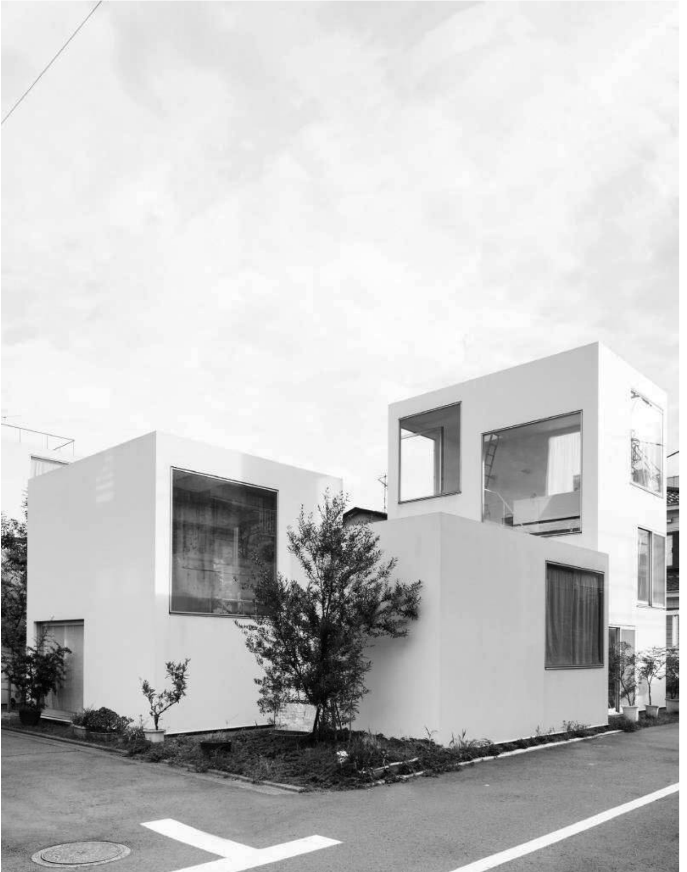
Abb. 20. Sicht auf die Wohneinheiten A, I und J von der Strasse.
