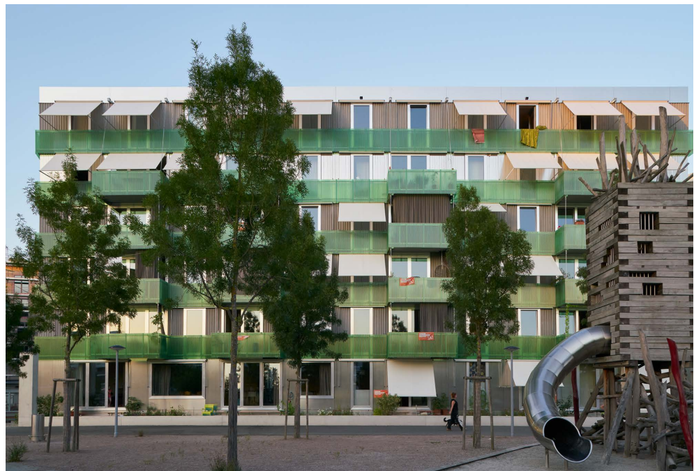
Abb.9. Fassade, Stadterle Basel.
