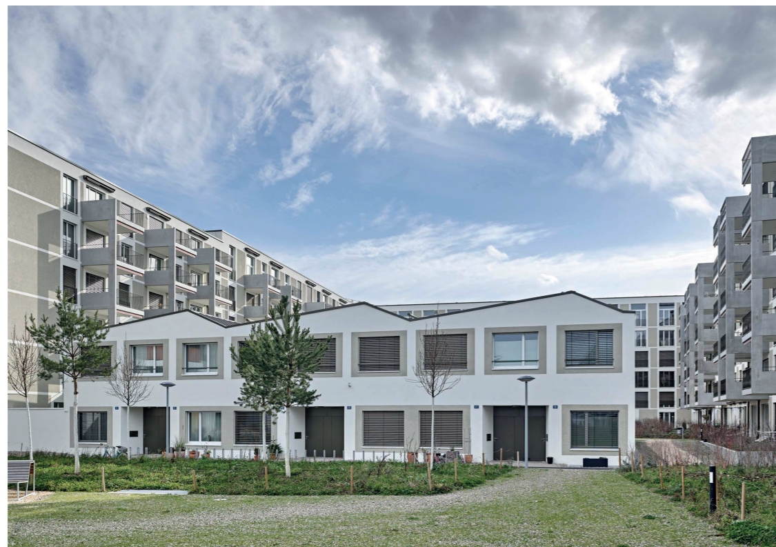
Erlenmatt West, Innenhof Baufeld E mit Reiheneinfamilienhäuser
