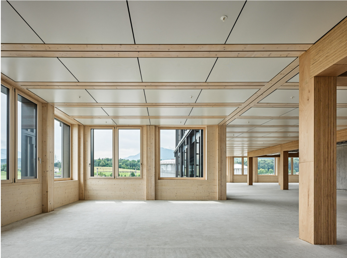
Abb. 2: Holzstruktur im Innenraum des «Suurstoffi 22». (Frei, Roger, 2018)
