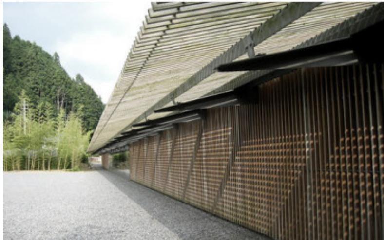
**Abb.61.** Das markante Element des Hiroshige Museum von Kengo Kuma ist das grosse Dach mit dem leichten Vordach, das eine Zwischenzone von aussen nach innen bildet.
