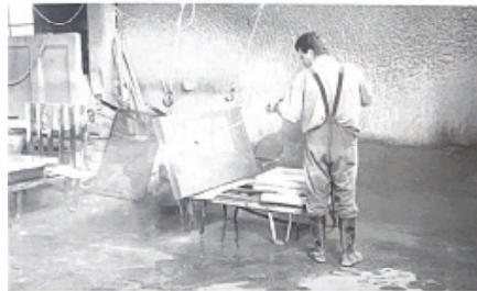
Die nicht abgedeckten Flächen des Betons werden herausgespritzt. The unset surfaces of the concrete are sprayed out.
