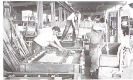
Siebdruckfolie und Beton werden in Formen gefüllt. Silk screen foil and concrete are poured into moulds.
