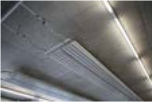
Maschinenraum Deckenstrahlplatten
