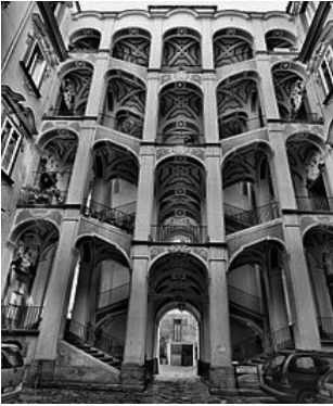
Abb. 1. Grosszügige Treppenanlage im Palazzo dello Spagnolo in Neapel, gebaut 1742
