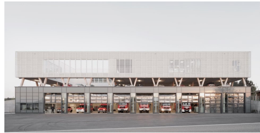
Feuerwehrhaus, Straubenhardt, 2022, Deutschland Bildquelle © Brigida González für Wulf Architekten
