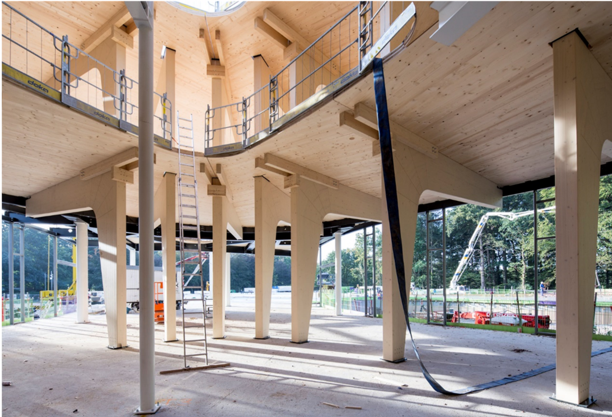
Abbildung 21: Montage tragendes Stützensystem aus Brettschichtholz mit Brettsper Holzdecken, © Carel van Hees
