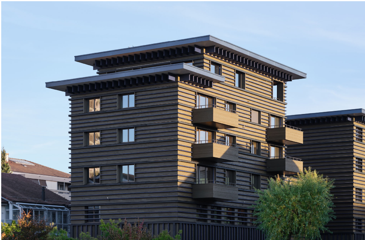
Abbildung 26: Haus des Holzes in Sursee in der Schweiz, © Pirmin Jung Schweiz AG, Foto: Marco Leu
