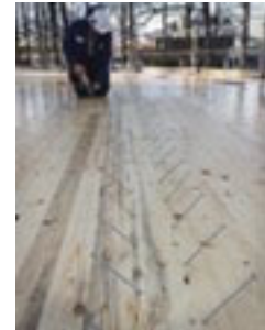
Abbildung 6: Kreuzverschraubung Deckenelement © Rau Architects
