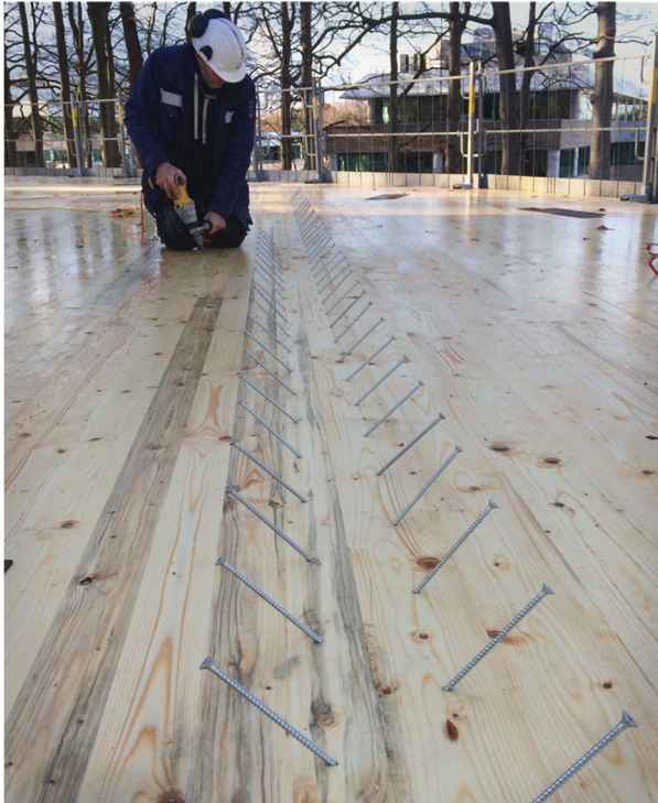
Abbildung 22: kraftschlüssige Verbindung durch Verschraubung, © Rau Architekten
