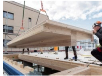
Abbildung 11: Montage Deckenelement © Pirmin Jung Schweiz AG
