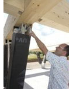
Abbildung 9: Stützenanschluss Träger © Wulf Architekten
