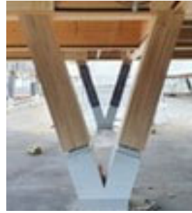
Abbildung 8: Stützenansicht Parkdeck © Wulf Architekten
