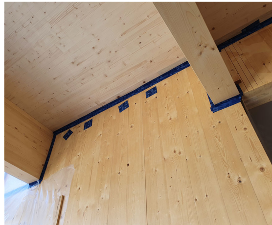
Abbildung 25: Großflächige Wand- und Deckenelemente aus Brettspertholzelementen. © Wulf Architekten
