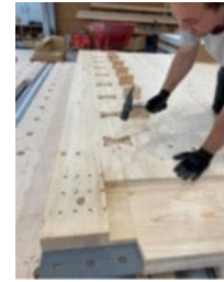
Abbildung 12: Steckverbindung Brettsperrholz © Pirmin Jung Schweiz AG
