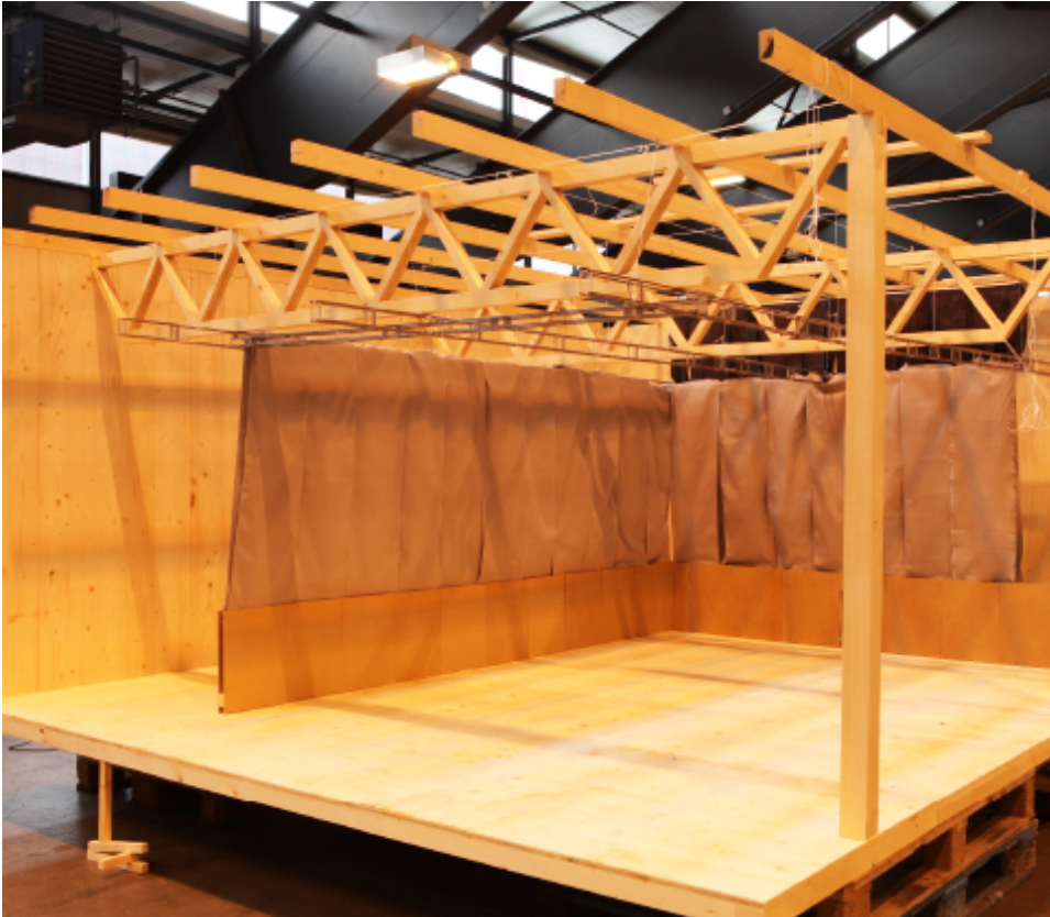
Definitive Systemwahl, Feste Wand auf Boden, vertikaler textiler Vorhang (akustisch wirksam) und Aufhängung Deckenhimmel an Eurotruss-Rahmen
