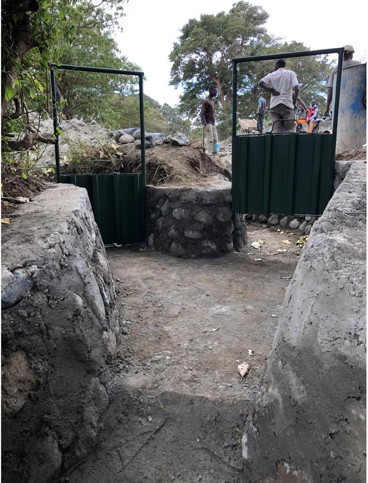
Abb. 10 – Schleusensystem der Wasserfassung.
