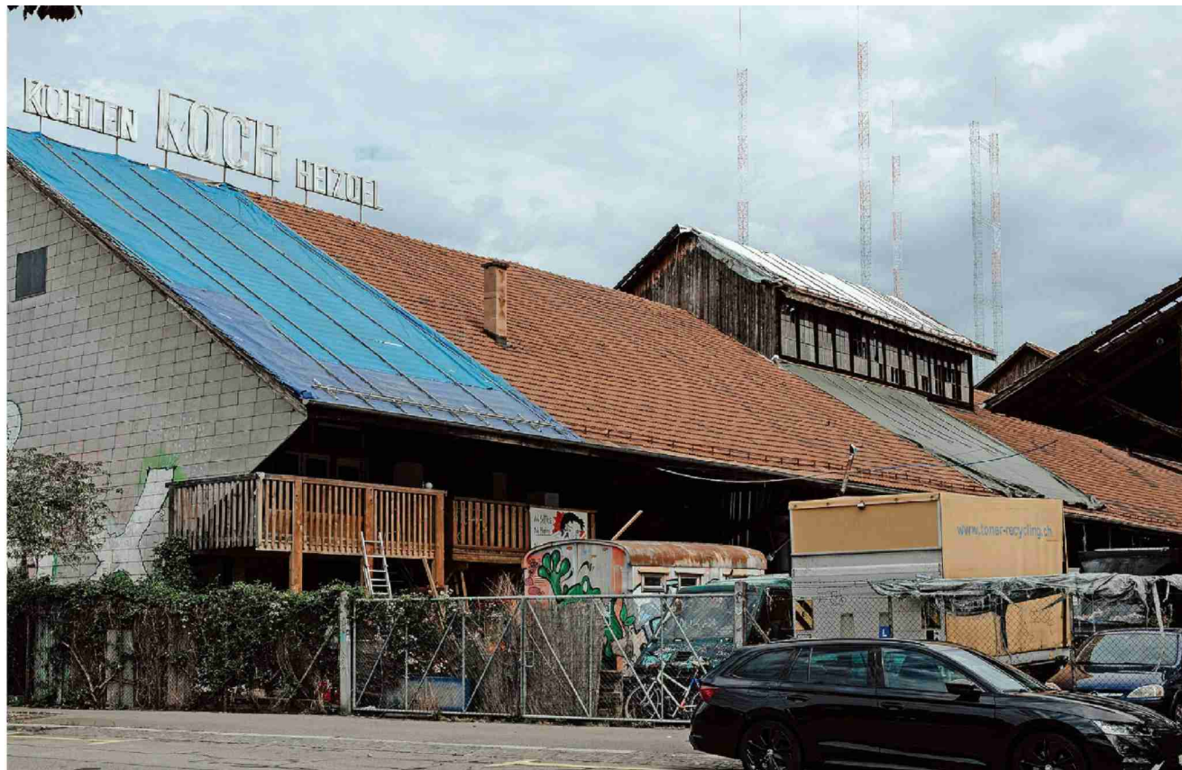
Heute noch besetzt: In einigen Jahren gibt es auf dem Areal einen 12'000-Quadratmeter-Park und einen Genossenschafts-Tower. Foto: Silas Zindel
